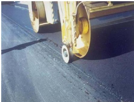
Рис. 17. Краевой уплотнитель на ведущем вальце катка
