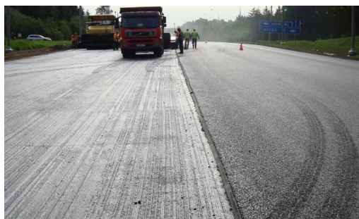
Рис. 23. Укладка стыковочной ленты вдоль кромки покрытия
