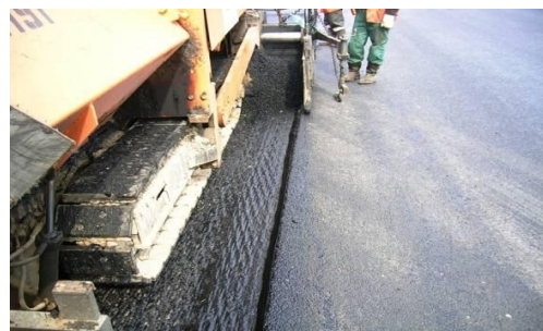
Рис. 24. Укладка смеси с применением стыковочной ленты
