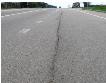
Рис. 2. Технологическая трещина
