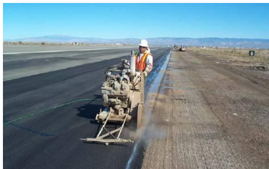
Рис. 13. Обрезка кромки алмазным диском
