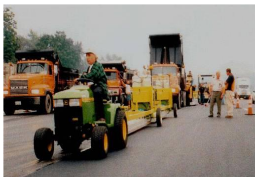
Рис. 15. Система инфракрасного прогрева на автономном шасси
