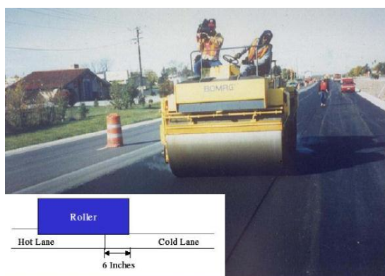
Рис. 25. Уплотнение с перекрытием смежной полосы
