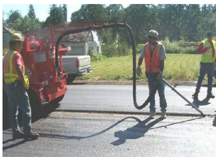
Рис. 21. Специализированный заливщик для нанесения мастики
